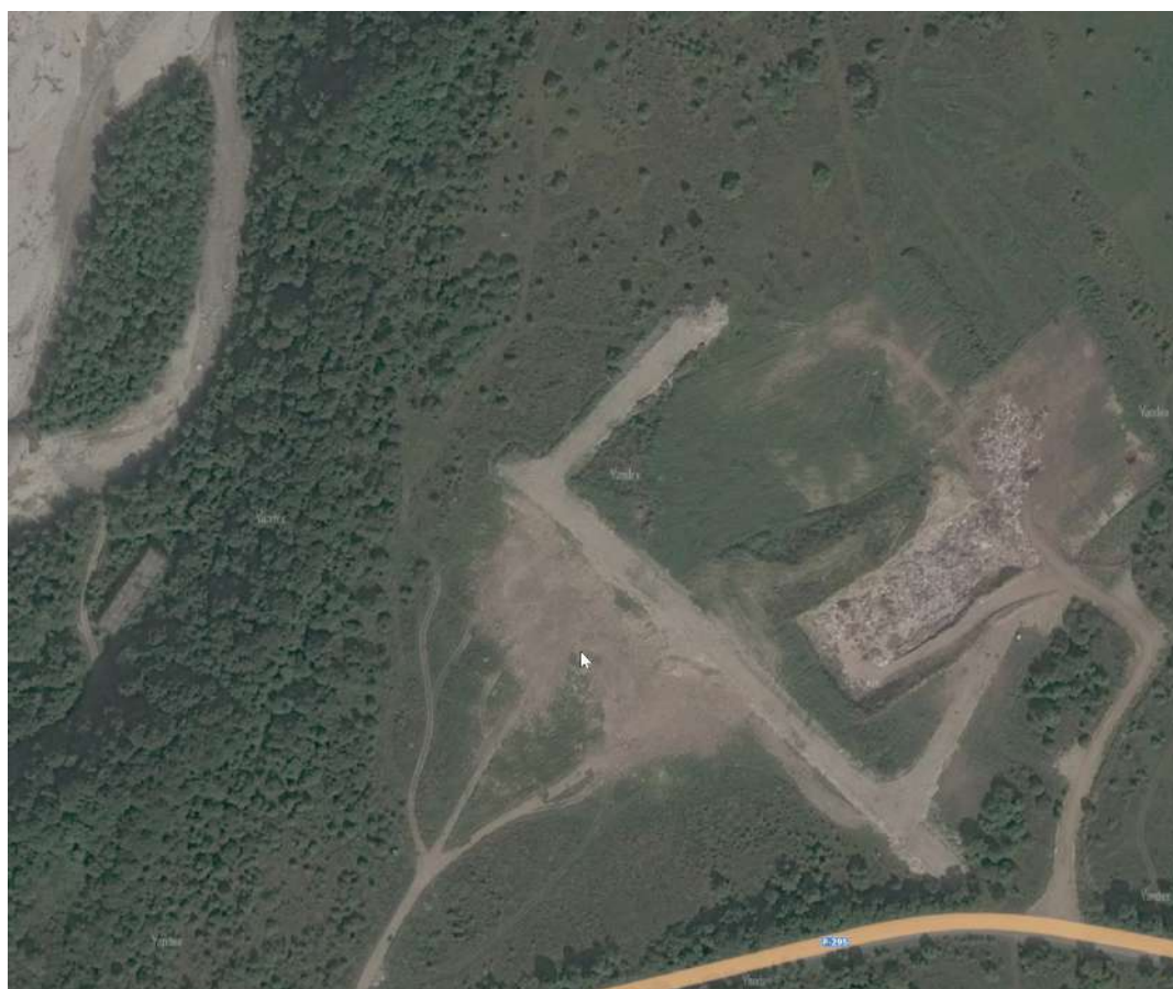
Рисунок 7.5.8 Размещение несанкционированного места накопления ТКО в с. Чикола (Ирафский район)
